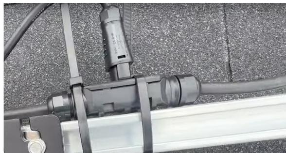
Instalar los micros a la estructura con material provisto por el distribuidor compatible con la estructura. Sujetar los conectores a los rieles para una instalación limpia y segura
